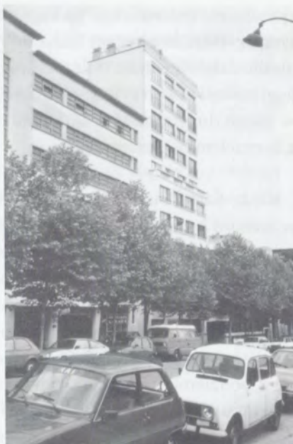
Budynek przy 38, Boulevard Saint-Jacques, lata osiemdziesiąte.
