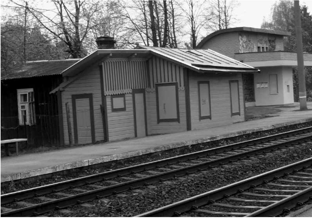
Stacja kolejowa w Kolonii Wileńskiej.
