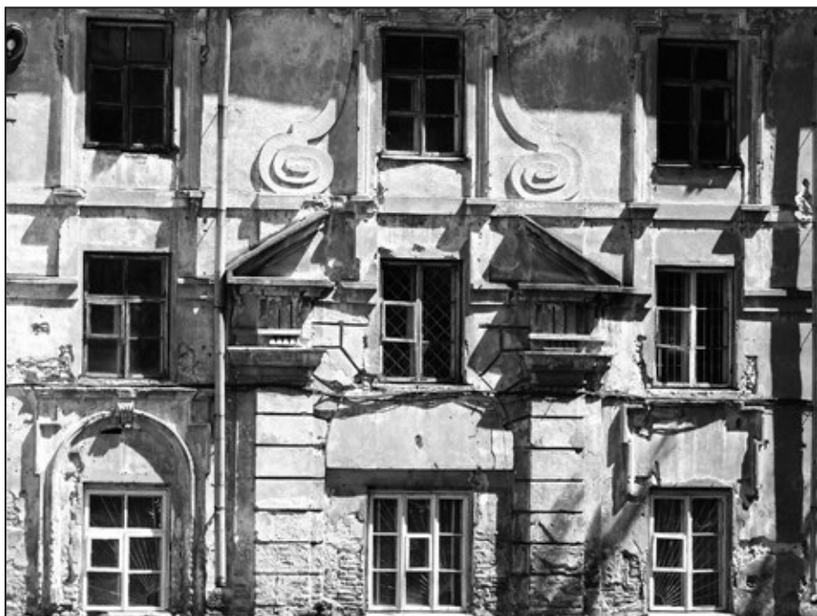
Pałac Radziwiłłów, obecnie podczas generalnego remontu
