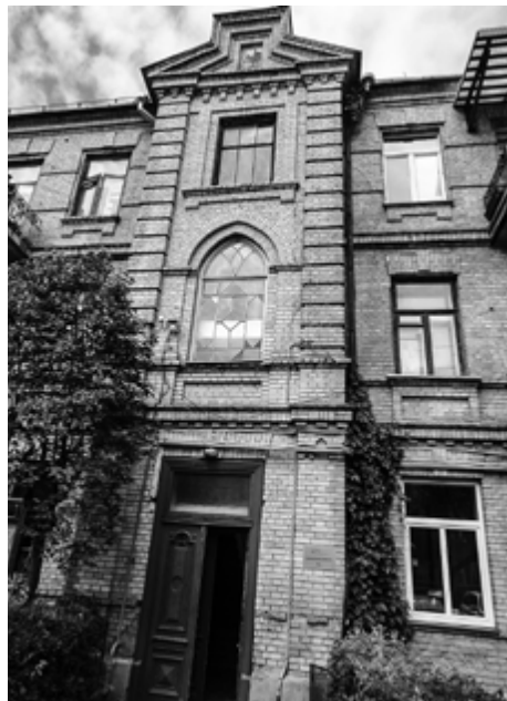
Dom przy ul. Podgórnej
